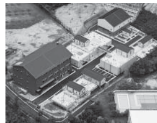
▲星の里浄水場
