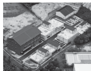
▲星の里浄水場
