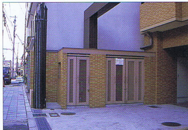
建築物の壁面と同じ素材を用い壁面が一体的に見えるようデザインする。
