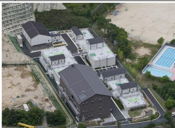
星の里浄水場
