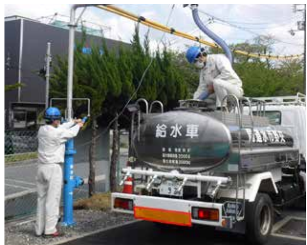
緊急時用給水栓から注水する様子
