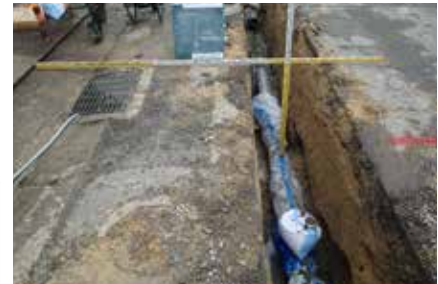
水道管工事の様子
