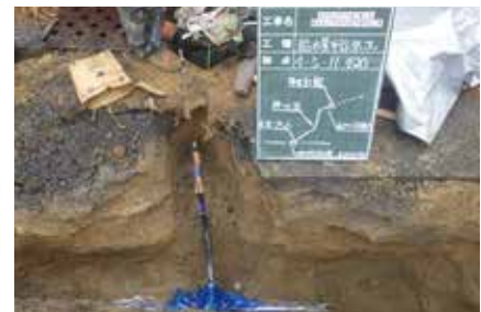
給水管取替の様子
