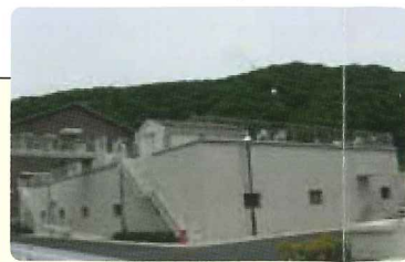
▲生物接触ろ過池
