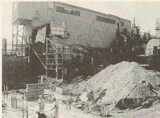
工事中のごみ焼却場
