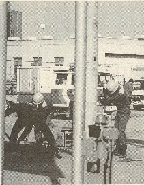
ライフラインの復旧訓練
