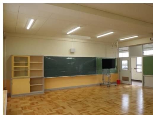
旧ランチルームを更新した普通教室。他の教室と同じ設えとし、傷んでいたビニル系床も学校フローリングに。
