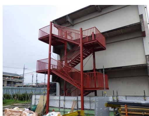
既存校舎北側の屋外避難階段の錆びなどを綺麗に除去し、避難時に安心して使用できるよう、補修しました。
