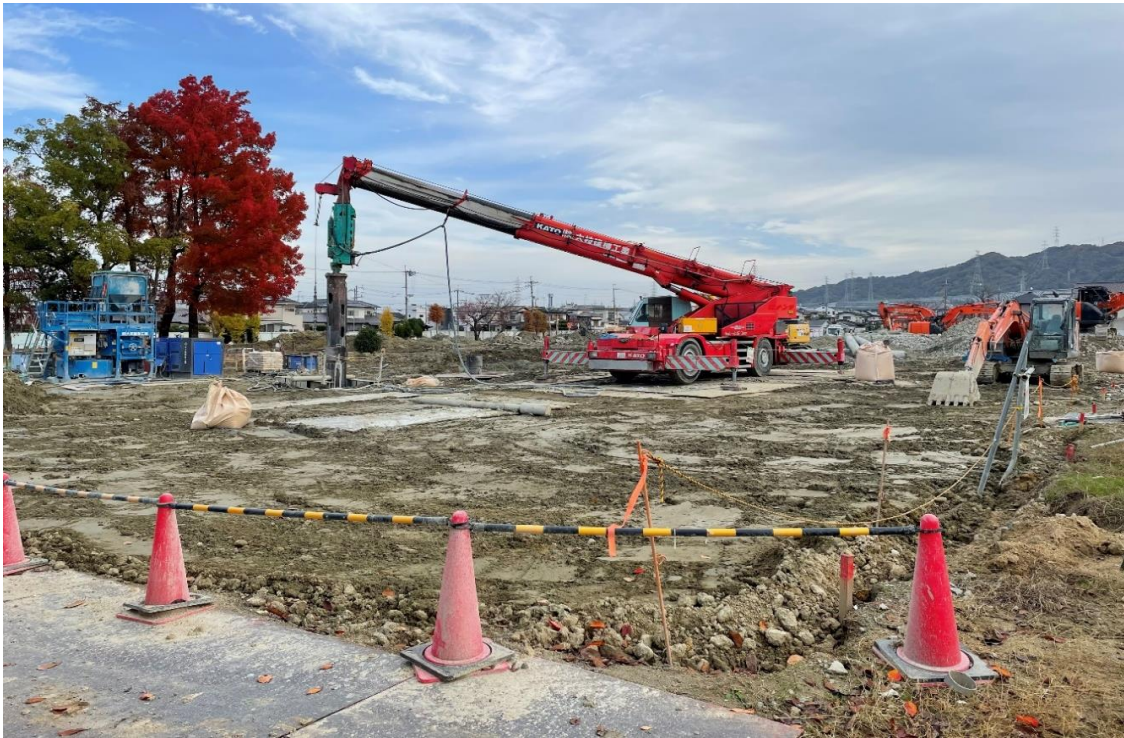
説明 杭抜き工事
