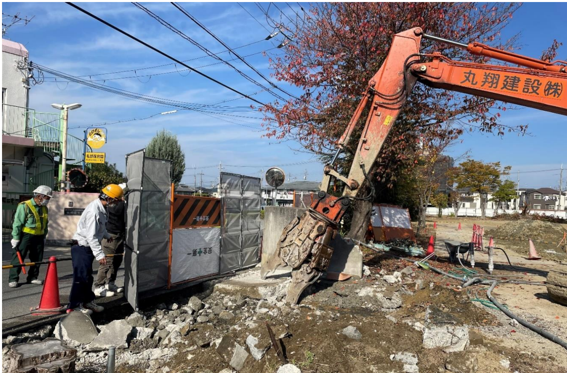
説明 外構解体状況
