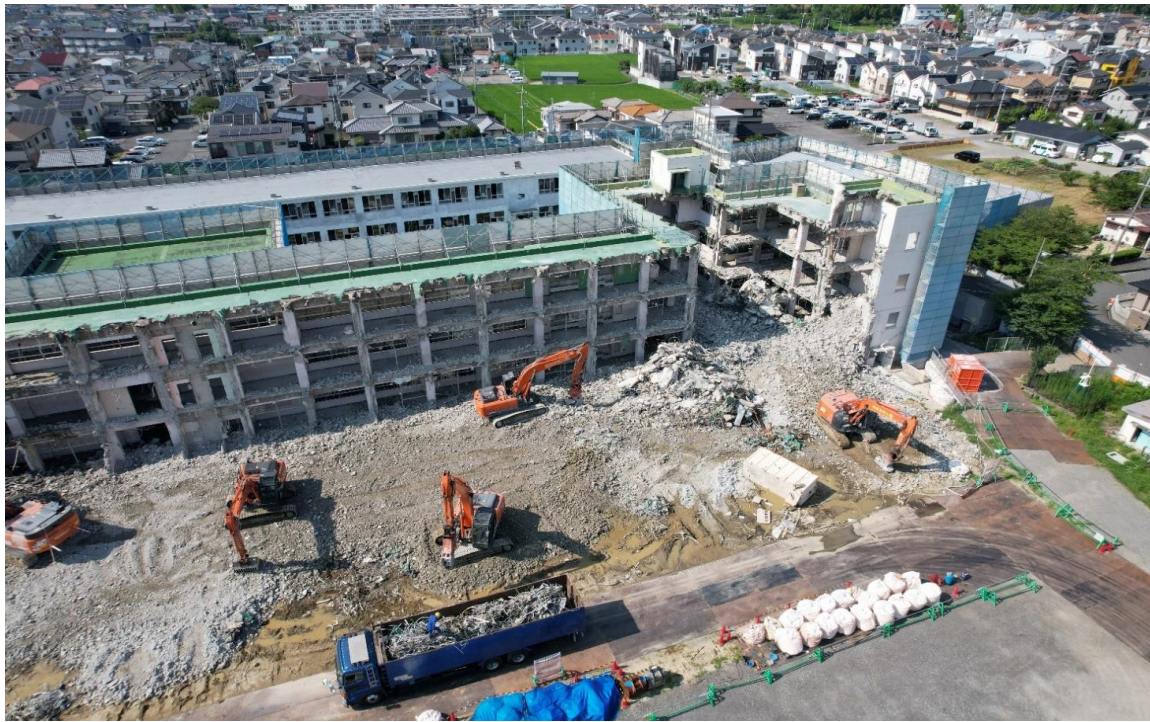
説明 南棟躯体解体工事
