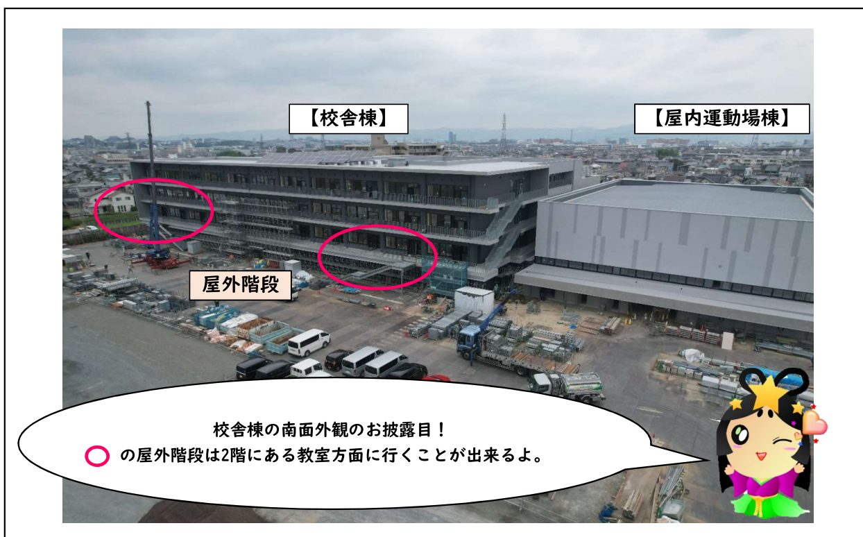
説明 【校舎棟】外装・外構工事施工状況 撮影箇所 南東側より撮影
