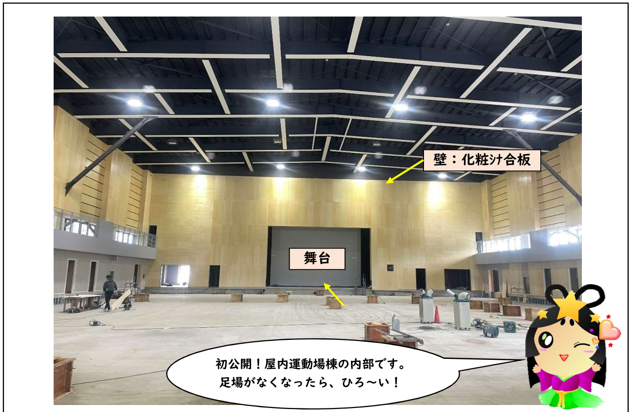
説明 【屋内運動場棟】1階 内部仕上げ工事状況 撮影箇所 南側入口より撮影
