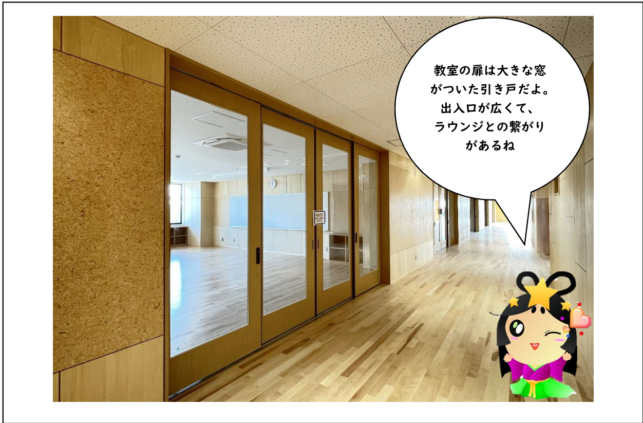
説明 【校舎棟】 共用部 内装仕上げ工事状況 撮影箇所 校舎棟 共用部より撮影
