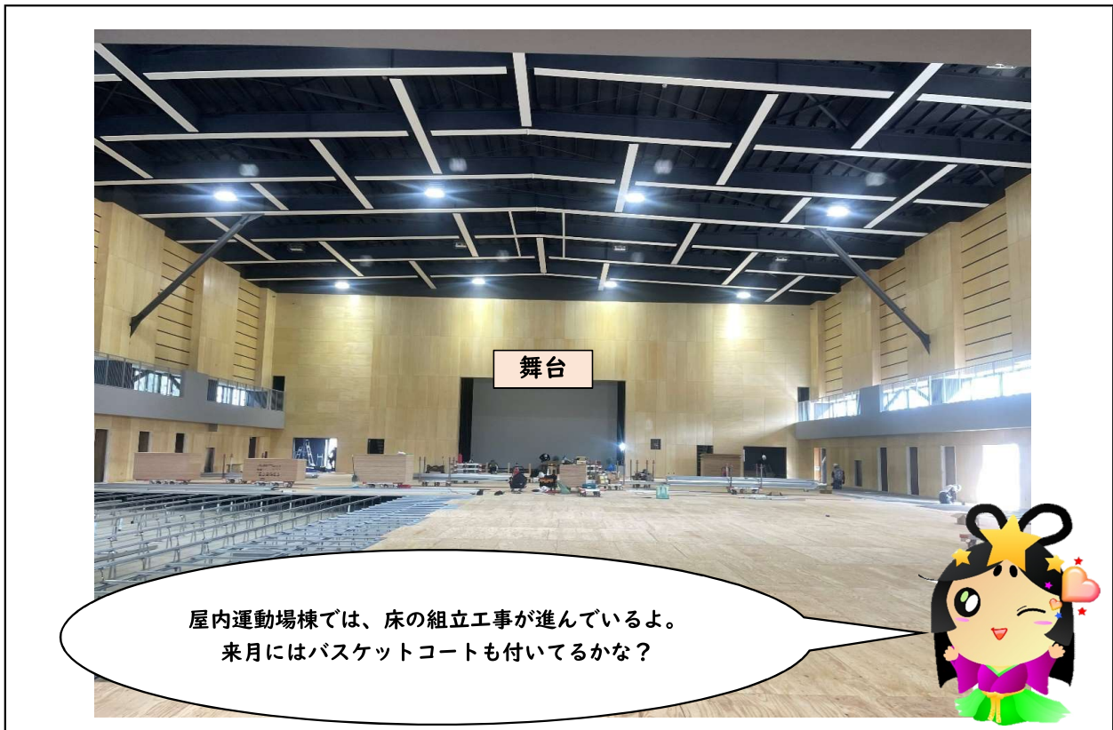
説明 【屋内運動場棟】 1階 内部仕上工事状況 撮影箇所 南側より撮影
