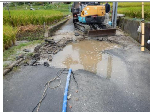
経年劣化による漏水
