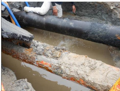
経年劣化による漏水
