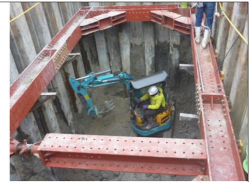
企業団受水管布設替工事 (JR下)
