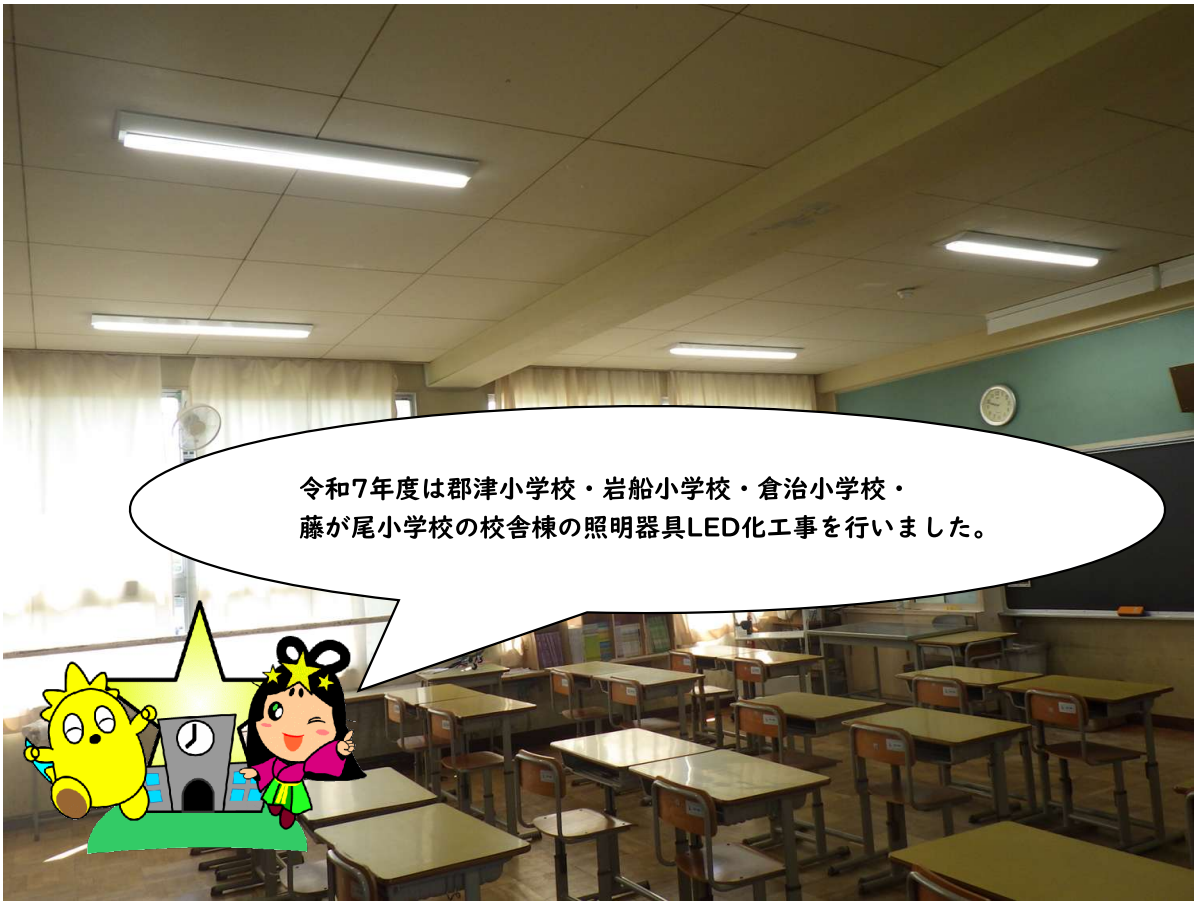
校舎棟照明器具LED化工事 (写真は藤が尾小学校)
