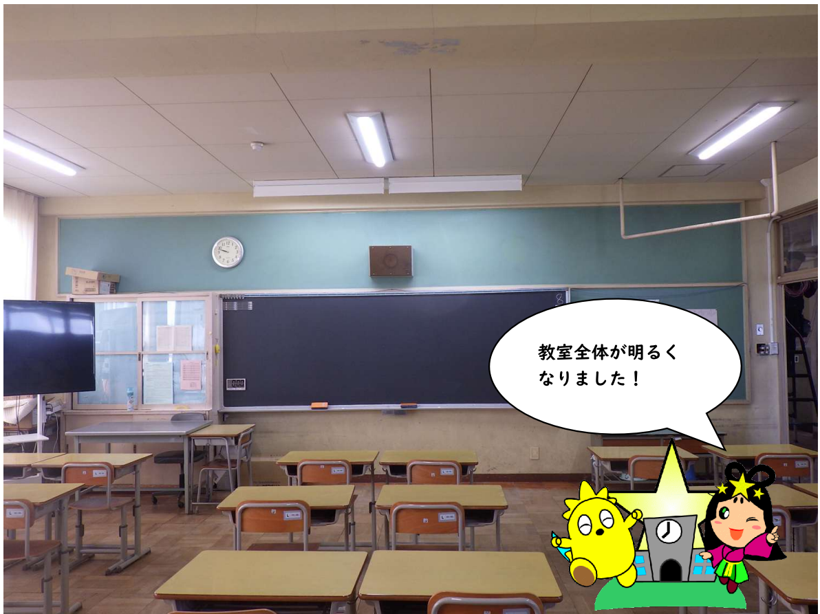
校舎棟照明器具LED化工事 ポイント1 (写真は藤が尾小学校)
