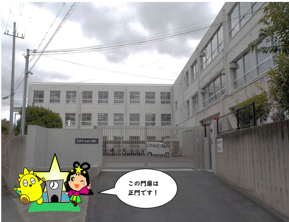
門扉改修・防犯設備工事 (写真は旭小学校)
