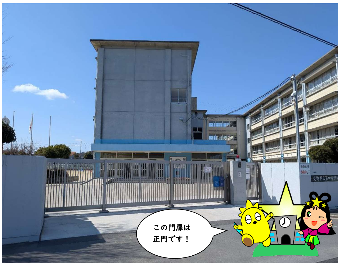
門扉改修・防犯設備工事 (写真は第四中学校)
