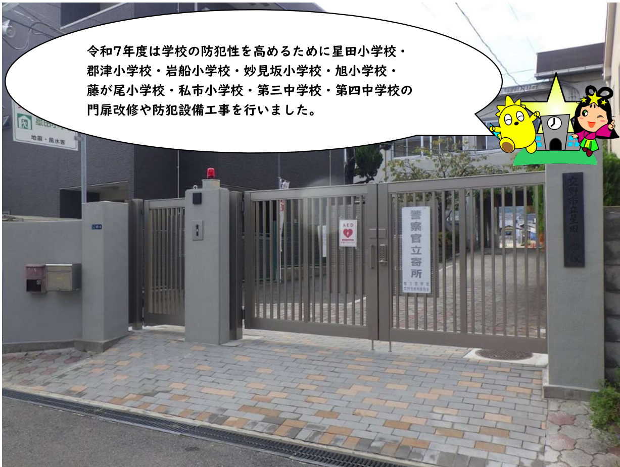
門扉改修・防犯設備工事 (写真は星田小学校)
