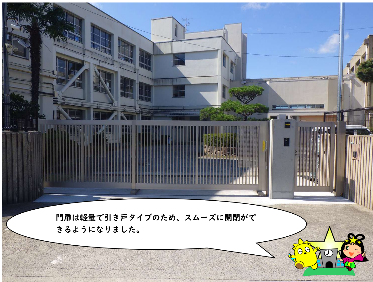
門扉改修・防犯設備工事 (写真は岩船小学校)
