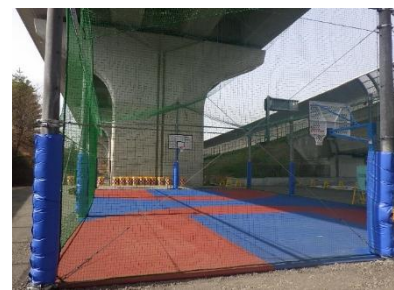
倉治1丁目高架下ボール遊び広場
